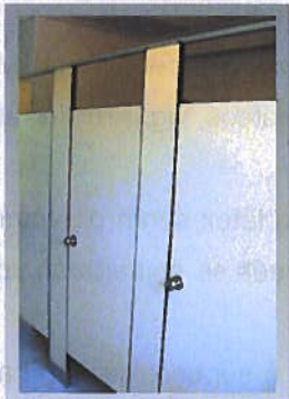
Tabiquería para sanitarios
