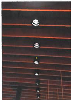
Cielorraso de lamas de madera sostenido por estructura metálica
